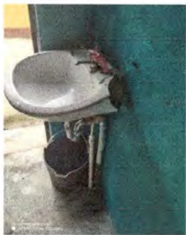
Foto1: Sustitución de 2 lavamanos
