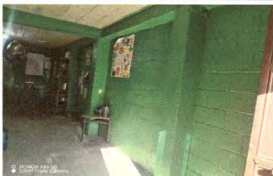
Foto 3: Pintura de muros exteriores e interiores 4 mts de ancho x 10 mts de largo
