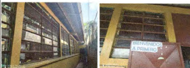
Foto 6: Sustitución de 25 vidrios. 23 vidrios de 20 x 75 y 2 vidrios de 18 x 75
