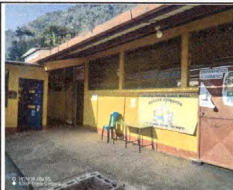
Foto1: Sustitución de puertas en 3 aulas y cocina 2 puertas de 0.98 de ancho x 1.99 de alto 2 puertas de 1.02 de ancho x 2.10 de alto
