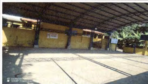
Foto 2: pintura de muros exteriores e interiores cancha 17.52 mts de largo x 11.78 mts de ancho
