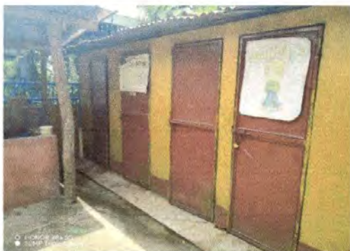
Foto 3: Sustitución de puertas en servicios sanitarios 3 puertas de 0.61 de ancho x 1.73 de alto, 1 puerta de 0.59 de ancho x 1.73 de alto
